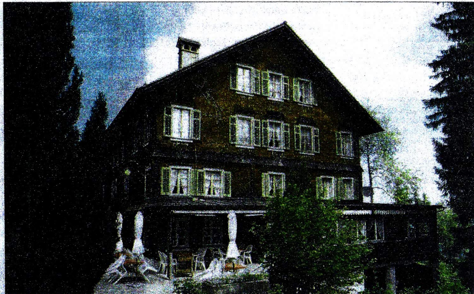
So sieht das Restaurant Hergiswald heute aus. Das Neubauprojekt sah vor, es abzureissen und zu ersetzen.
